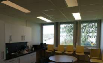
Salle de convivialité à la cité administrative après travaux
